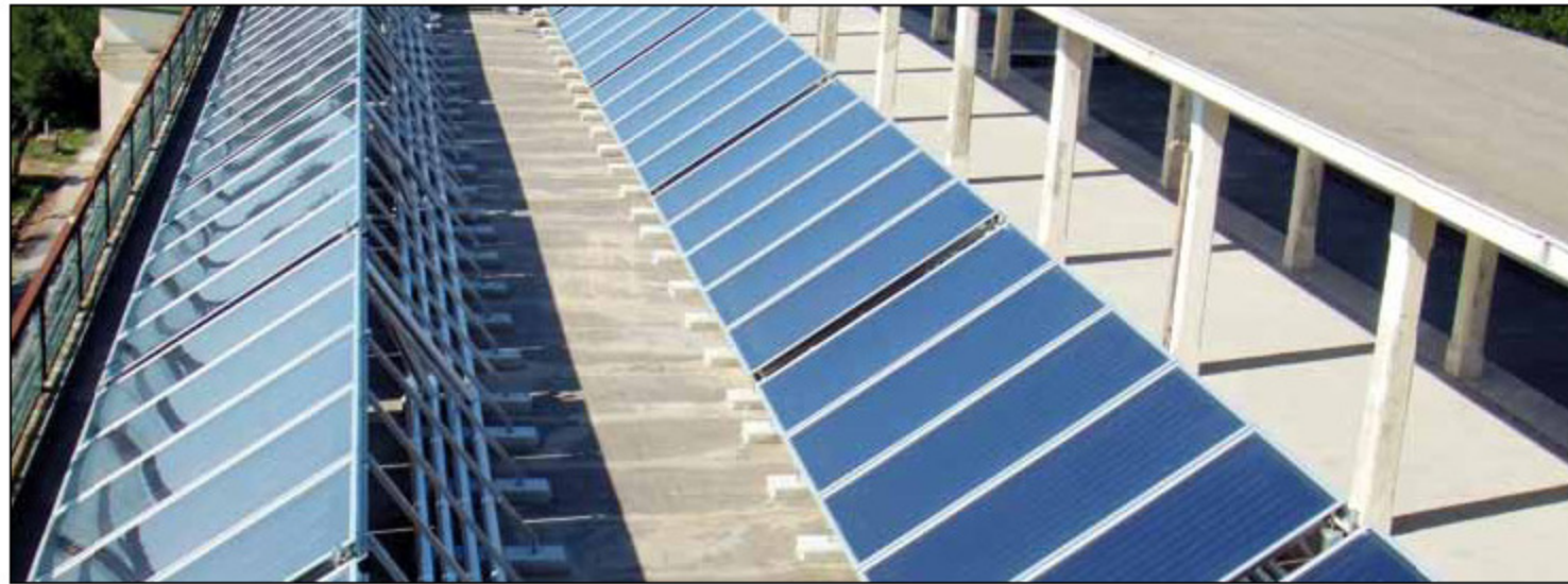
La collaborazione ha consentito, tra l'altro, di formare operatori consapevoli nel campo dell'installazione e manutenzione degli impianti fotovoltaici, settore in rapida espansione, che avrà bisogno sempre più di addetti
